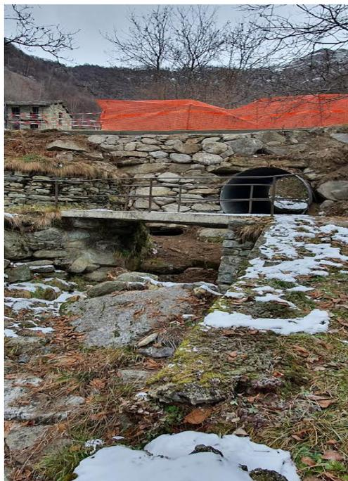
Ormai da tempo le spallette del ponte di attraversamento del Rio di Frachiamo presentavano importanti segni di cedimento. È stato realizzato un intervento radicale, di demolizione e ricostruzione delle strutture in pietra, mettendo in sicurezza il deflusso del torrente, la strada carreggiabile sovrastante e il sentiero pedonale a valle. Completamente realizzato con una scheda PMO.
